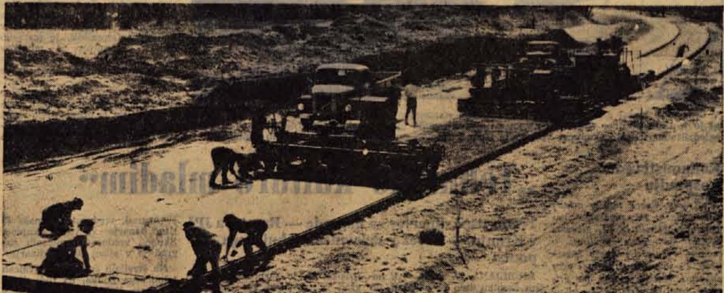
V nadaljevanju del pri izgradnji nove gorenjske magistrale so v Bestrici pričeli betonirati še drugo polovico cestišča. Kot vse kaže, bo ta del ceste še najprej dokončan
