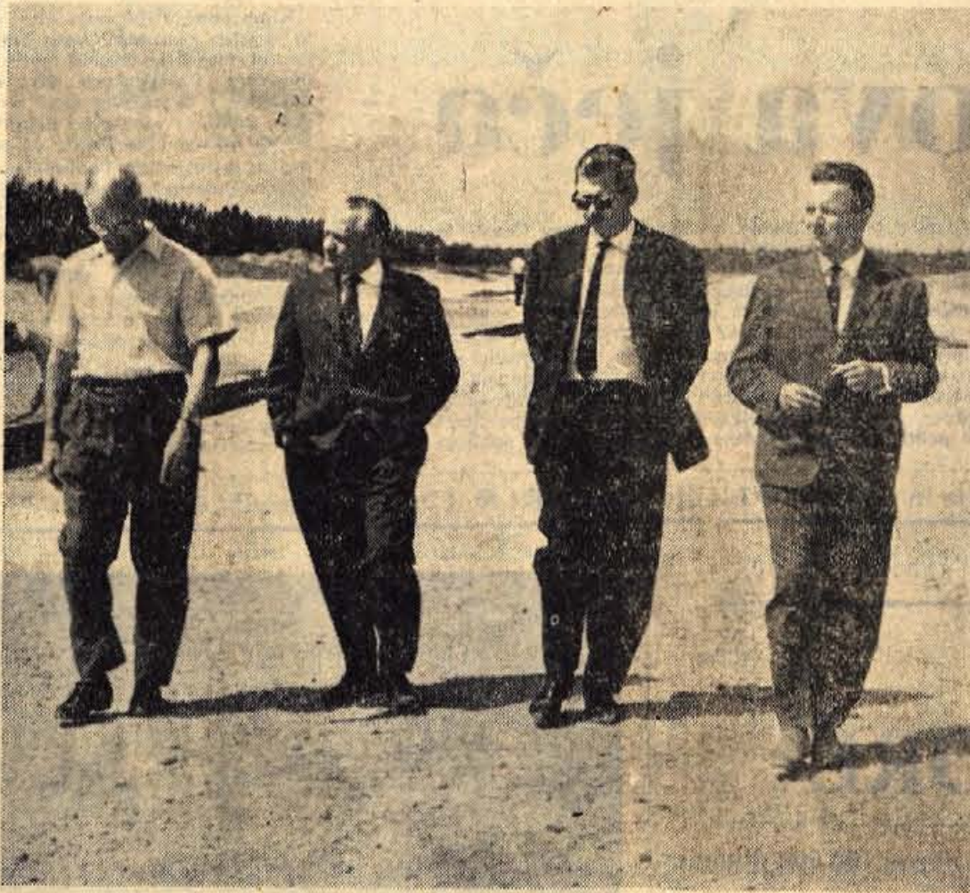
Jutri bodo na letališču v Brnikih pričeli betonirati drugi pas betonske vzletne steze. Tudi ta bo široka sedem metrov in pol, zraven njiho pa bodo kasneje zgradili še dve. — V sredo si je gradbišče v Brnikih ogledal predsednik Izvršnega sveta SRS VIKTOR AVBELJ in se s predstavniki investitorja in podjetij, ki izvajajo dela, pogovoril o sedanjem in prihodnjem delu pri izgradnji tega nadvse pomembnega objekta
