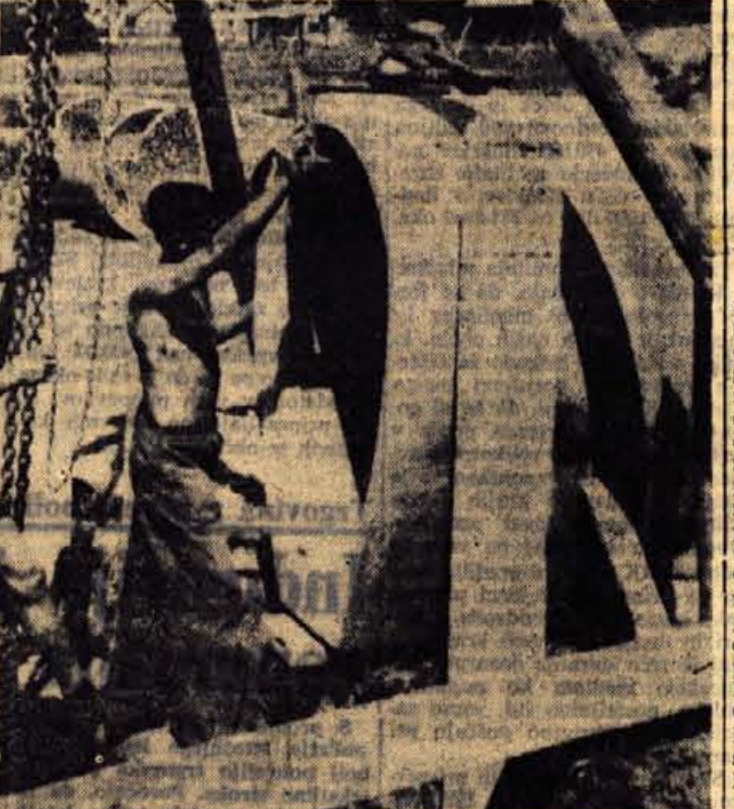
Delavci komunalnega podjetja Remont v skofji Loki so na Suhl prišli graditi novo mestno kanalizacijo. Stroški za gradnjo od Suhe pri Sori, kjer bodo čistilne naprave, pa do sotočja obeh Sor v mestu, bodo znašali 75 milijonov dinarjev
