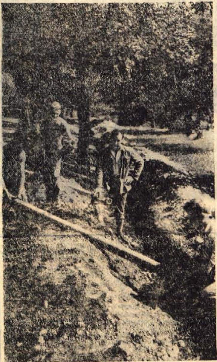
Dela pri gradnji vodovoda v Podnartu hitro napredujejo. Pri vodovodnem podjetju v Kamni gori, ki izvaja ta dela, pravijo, da bo voda po ceveh stekla še pred zimo.
