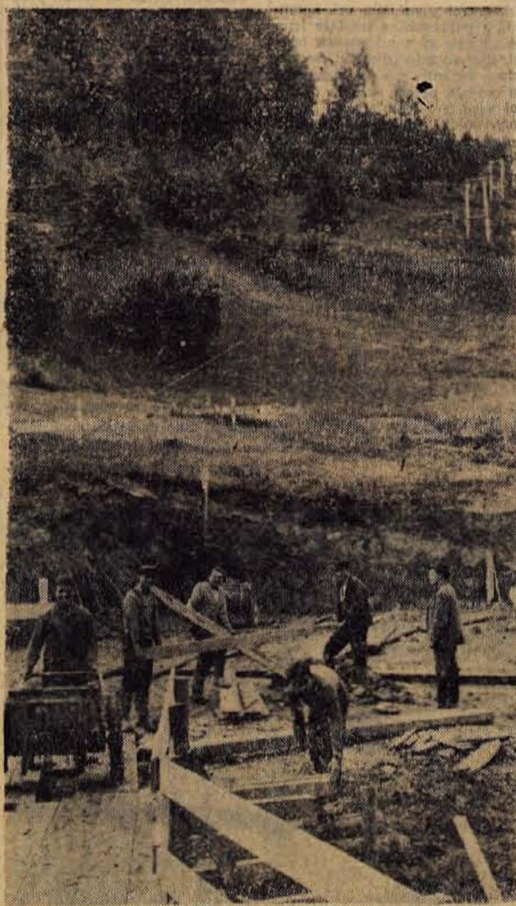
Zičnica s Planine pod Golico na Črni vrh ni več samo želja. Posnetek prikazuje začetek gradnje spodnje postaje žičnice. Ta bo velikega pomena za turizem in predvsem za zimski šport v tem predelu
