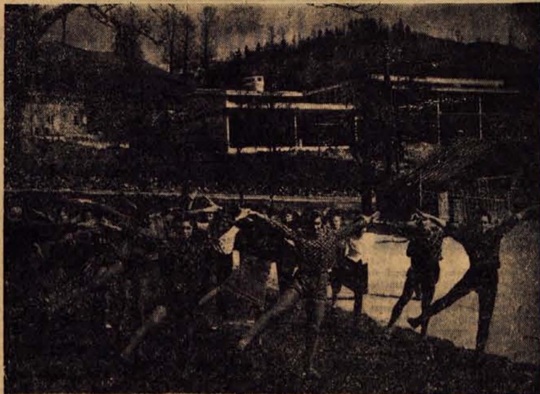
Gradnja največjega športnega objekta v trziški občini — novi stadion v Križah — poteka nadvse zadovoljivo. Če bo vreme tako naklonjeno, kot je sedaj, in če bo tudi dovolj pridnih prostovoljnih rok, bo objekt letos dograjen in bodo na njem že tudi prve športne prireditve. Za otvoritev pa je predviden velik telovadni nastop
