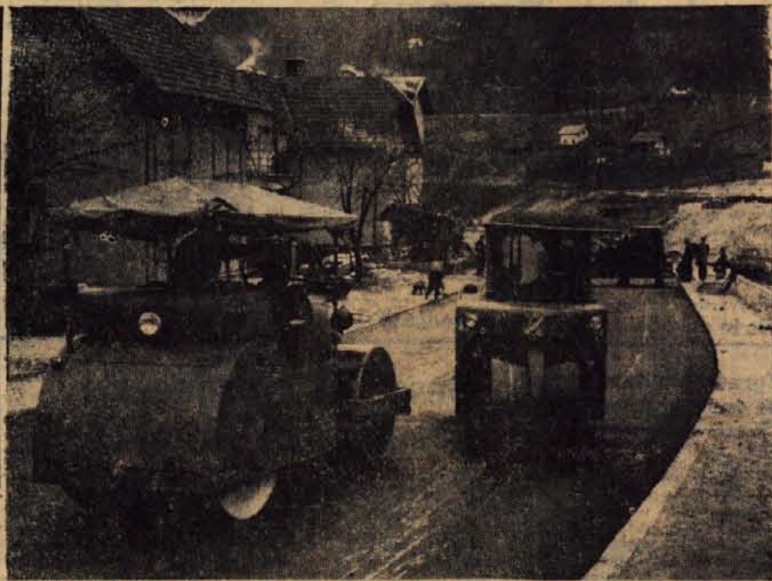
Te dni so asfaltirali cesto preko novega mostu čez Savo na Javorniku. Otvoritev ceste bo 1. maja in bo ena izmed največjih objektov, ki bodo ob tem prazniku izročeni svojemu namenu
