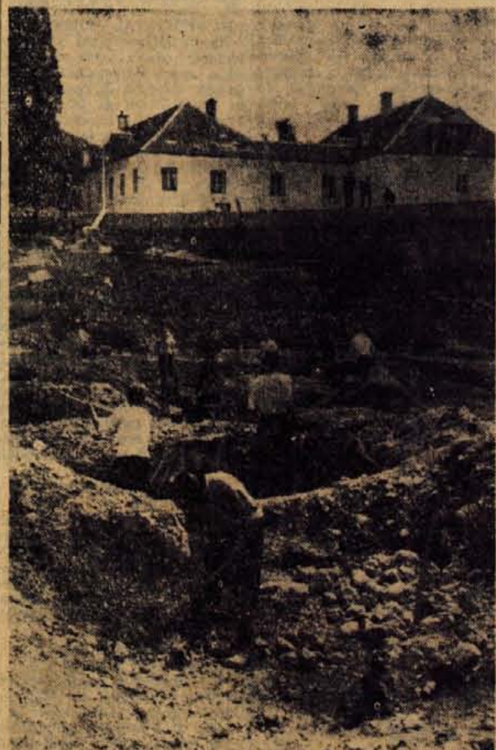
Cez dva ali tri tedne bo predvidoma zaključena sanacija umetnega jezera Crnjava v Preddvoru. Zaliti morajo okoli 50 požiralnikov, skozi katere je otekalo več vode, kot jo je v jezero pritekalo in odkrivalo nič kaj lep pogled na blatno jezersko dno. Dela finansira in opravlja Vodna skupnost Gorenjske. Za zalivke uporabljajo ilovico, ki jo lahko kopljejo kar ob bregu izsušenega jezera. Da v jezeru ne bi primanjkovalo vode, bodo speljali še en dotok
