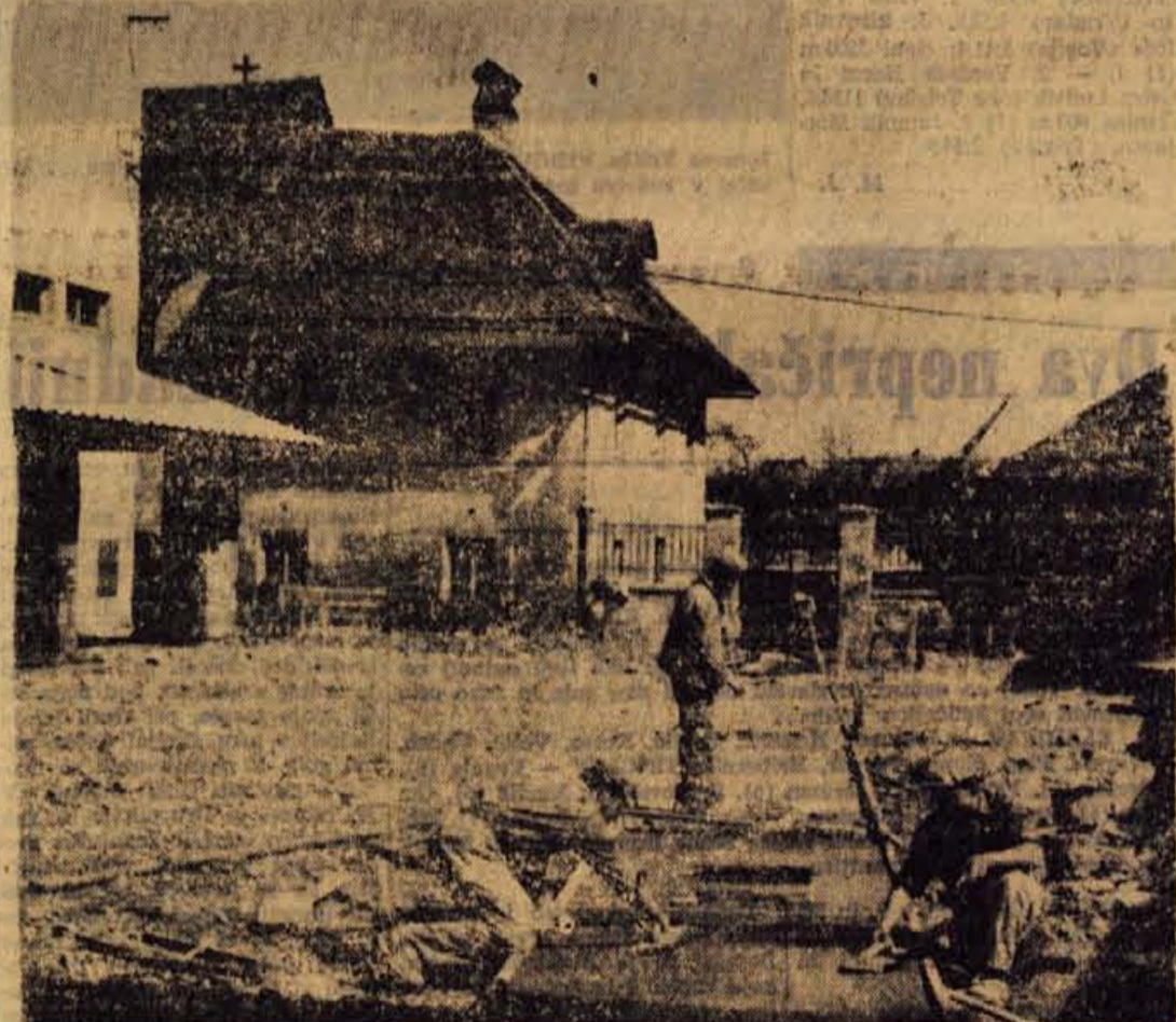
Pri tržnici v Kranju zaključujejo z gradbenimi deli in bo verjetno usposobljena do 1. maja. V istem času naj bi bil gotov tudi potrošniški center, ki ga urejuje podjetje Zivilla Kranj
