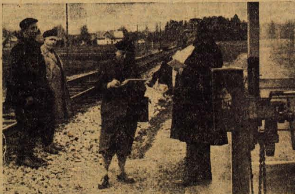
Posebna skupina strokovnjakov Združenja železniških transportnih podjetij iz Ljubljane že več dni pregleduje gorenjsko progo (tokrat brez prvopriprilne šale). Ob tem ogledujejo, beležijo in skicirajo stanje proge za izdelavo načrtov telekomunikacijskih in signalno-varnostnih naprav. Na sliki: ogled proge med Jeprco in Godešičem pri Skofji Loki
