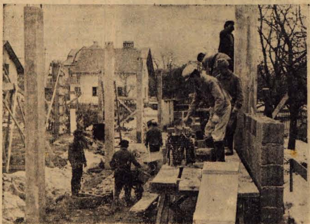
Delavci SGP Gorenje iz Radovljice ob Ljubljanski cesti nadaljujejo v jeseni začetno gradnjo objekta, kjer bosta končno dobili primerne prostore obrtni podjetji Tapetništvo in Ključavničarstvo
