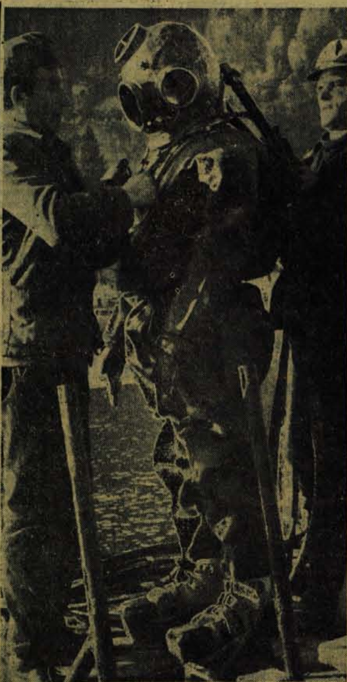
V ponedeljek so končali s prvo etapo polaganja 100 metrov dolgega cevovoda 10—15 m globoko pod jezersko gladino. V teh dneh pa bodo začeli s drugo etapo, položili bodo 300 metrov dolg cevovod. Na sliki: potapljač mariborskega podjetja »Tehnogradnja« pred odhodom na delovno mesto pod gladino Blejskega jezera, kjer sestavlja posamezne dele cevi
