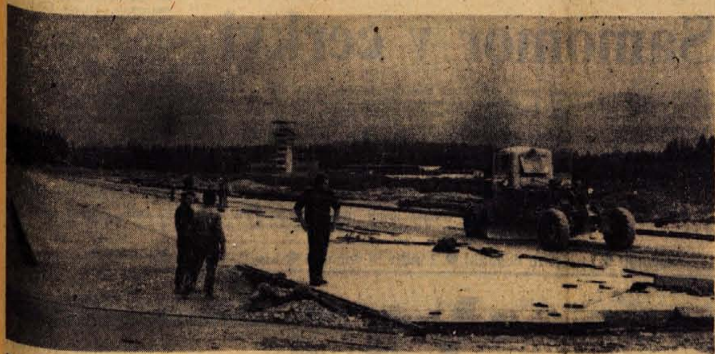
Na letališču Ljubljana-Brniki gradijo stezo, ki bo povezovala leta lično stezo s hangarji in ostalimi poslopi
