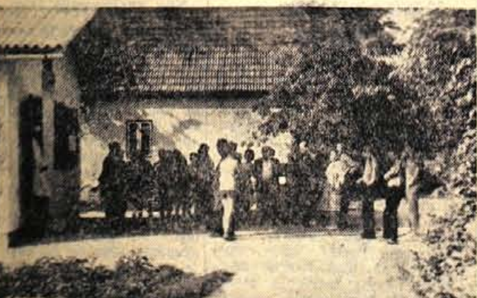
Pred praznikom dneva vstaje — v soboto, 21. julija, dopoldne so v Retečah pri Skofji Loki odprli novo mesnico, ki so jo vaščani zgradili pretežno s prostovoljnimi delom. Gradnja je stala približno milijon dinarjev. V tem kraju so bili doslej brez mesnice, zato je novi lokal za prebivalce nedvomno pomembna pridobitev. V novozgrajenem lokalu je poslovalnica skofjeloske »Mesnine«
