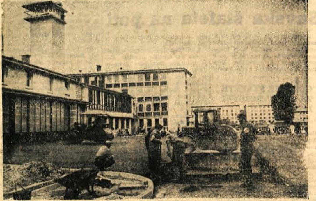
KRANJ - Severni del Kranja iz dneva v dan spreminja podoba. Ob novi sodobni pekarni, gasilskem domu, bodo kmalu uredili tudi okolico, novo cesjo itd. Zatem pa se bo pridružila še stolpnica - Foto: France Perdan
