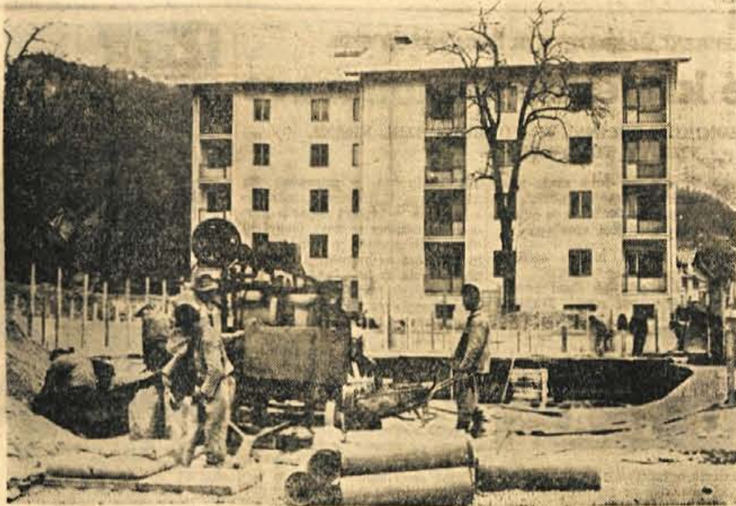
KOROŠKA BELA — Pri montaži strojev in naprav v novih valjarnah jeseniške Zvezarne na Belškem polju bodo sodelovali tudi strokovnjaki in monterji iz Združenih držav Amerike. Zato bodo na Koroški Beli zgradili za te ljudi samska stanovanja
