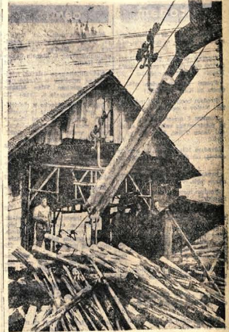
Spravilo velike večine lesa z Jelovice so letos preusmerili na žilnico »Jezerce«, ki je speljana v Sotesko. Žilničar Alfonz Podoreh, ki dela tu že 15 let, ima zato letos še posebno veliko dela. Na sliki: pri spodnji postaji žilnice. Les prihaja tu neposredno na železniške
