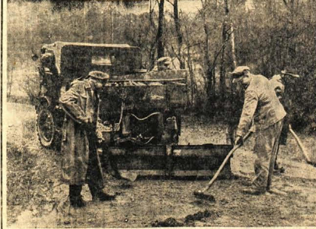
Te dni urejajo cesto med Kamno gorico in Lancovem. S temi deli bo cesta v glavnem tudi pripravljena za asfaltiranje, kar pa bodo naredili prihodnje leto
