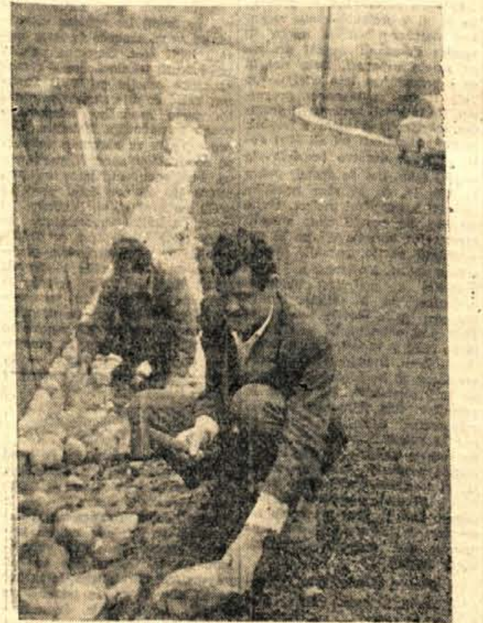
Cesta Radovljica-Lipnica je bila že nekaj let kamen spotike za domačine in za turiste, ki vsako leto v velikem številu radi zaidejo v Kropo. Že prihodnje leto pa bo tudi omenjena cesta asfaltirana. Letos so že asfaltirali del ceste iz Radovljice do mosta čez Savo in cesto skorzi Kamno gorico, z deli pa bodo nadaljevali prihodnjo pomlad. — Na sliki: Ureditve kanala ob novi asfaltni prevleki
