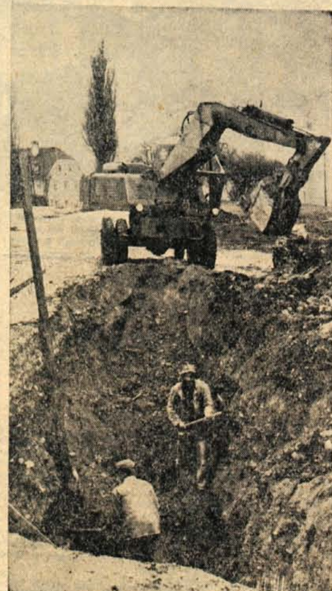
Pretekli ponedeljek je SGP »Projekt« iz Kranja začelo s prvinj deli za ureditev kanalizacije v Stražišču. Z deli so pričeli na Gašteju, ko bodo z gradnjo končali, pa bo kanalizacija urejena vse do Ješeta
