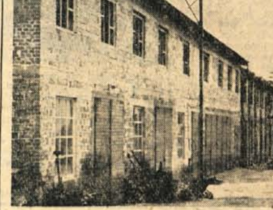
Za nove delavnice, skladišča in upravne prostore Gradbenega podjetja Tržič je bilo doslej investiranih okoli 100 milijonov dinarjev. V tem novem objektu bo tudi sedež novega združenega gradbenega podjetja
