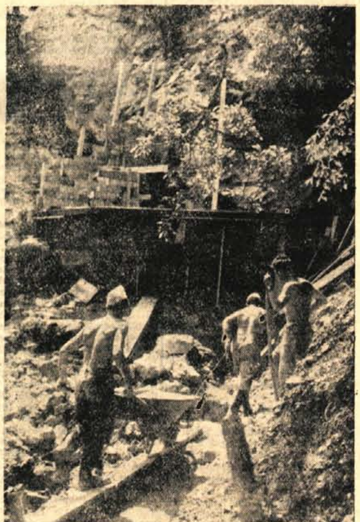
V Bohinjski Bistrici gradi komunalna uprava vodovod, ki bo končan najkasneje do dneva republike. Novo vodovodno omrežje, ki bo priključeno na staro, bo dolgo nad tri kilometre. Na sliki: dela pri zajetju Bohinjske Bistrice
