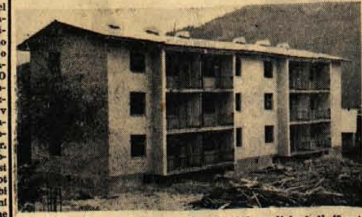
Stanovanjski blok v Bohinjski Bistrici, ki bo veljal okoli 40 milijonov, je dograjen. Se letos se bo vanj vselilo 12 družin gozdnih delavcev. Zgrajen je bil v enem letu
