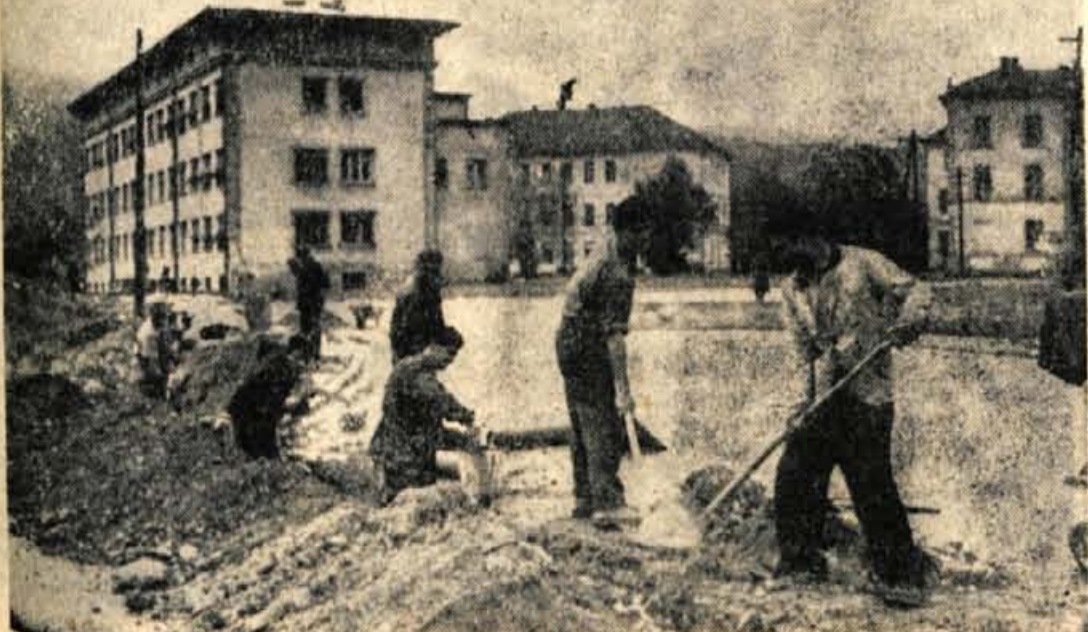
V Radovljici v teh dneh polagajo podzemni kabel za javno razsvetljavo
