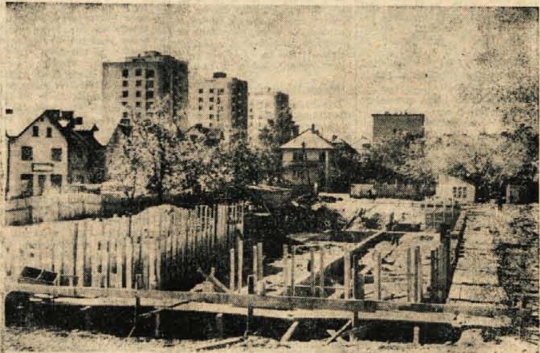
Novi predel Jesenic bo v bližnji prihodnosti dobil še en nov objekt — zdravstveni dom je že v gradnji
