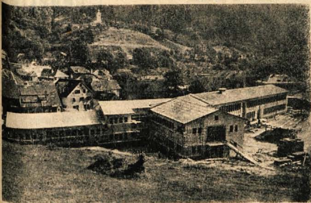
Nov pomemben objekt za vse prebivalce tržiške komune — zdravstveni dom — je v zaključni fazi gradnje, če bodo sredstva in če bo vreme naklonjeno, bo otvoritev objekta že ob Dnevu republike
