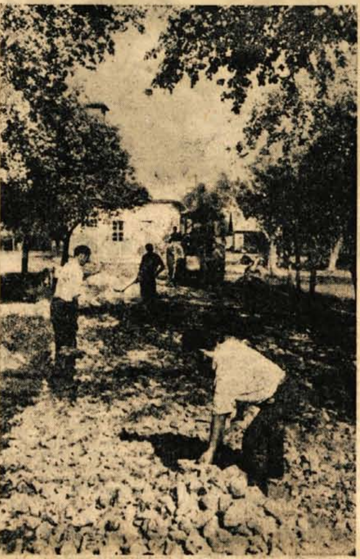
Asfaltiranje ceste Bled-Ribno
