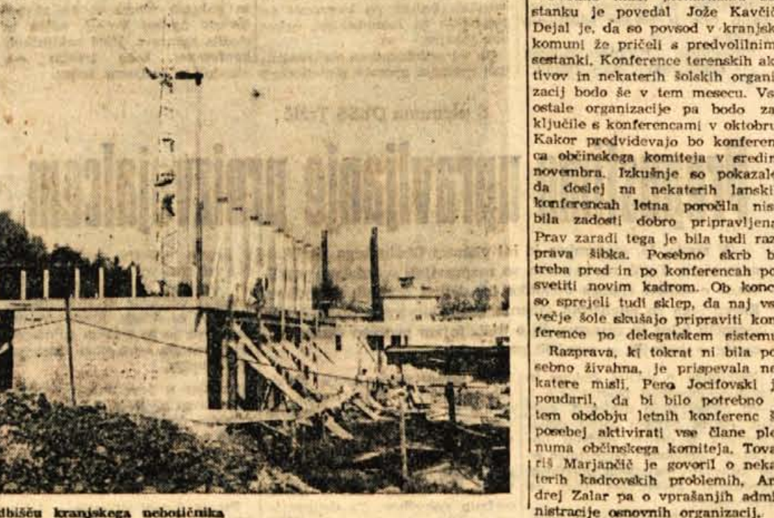
Na gradbišču kranjskega nebotičnika
