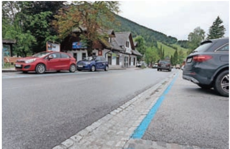
V središču Kranjske Gore se z zaključkom obnove ceste vzpostavlja modra cona in uvaja območje umirjenega prometa. / Foto: Gorazd Kavčič
