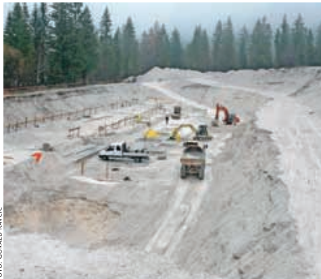
Velikanski izkop za novi osrednji objekt za smučarske teke, ki bo segal tri nadstropja v globino in dve v višino.
