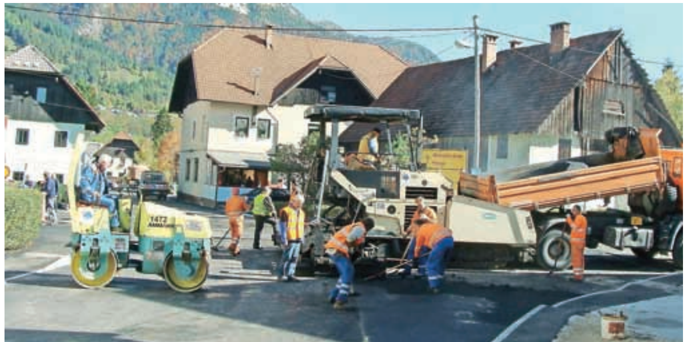
Jeseni so temeljito obnovili cesto skozi Mojstrano. / FOTO: GORAZD KAVČIČ
