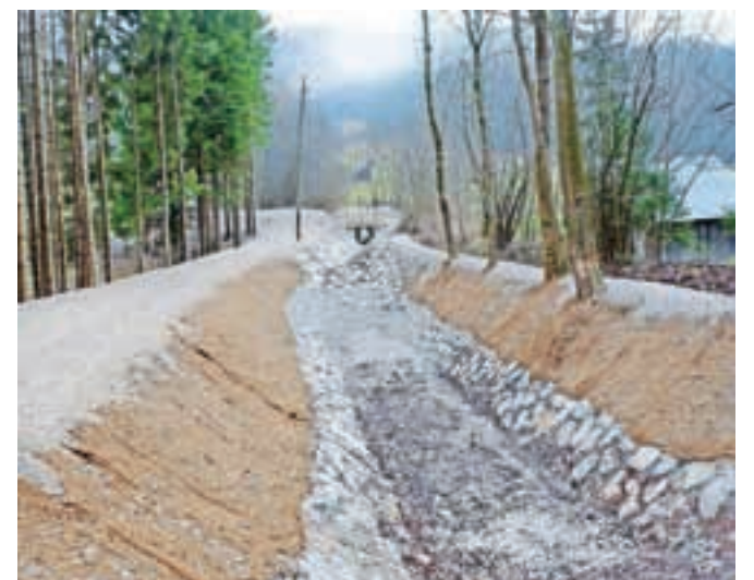
Vse ureditve so izvedene sonaravno, z minimalno količino betona, zagotavljajo na zavodu za varstvo narave.
