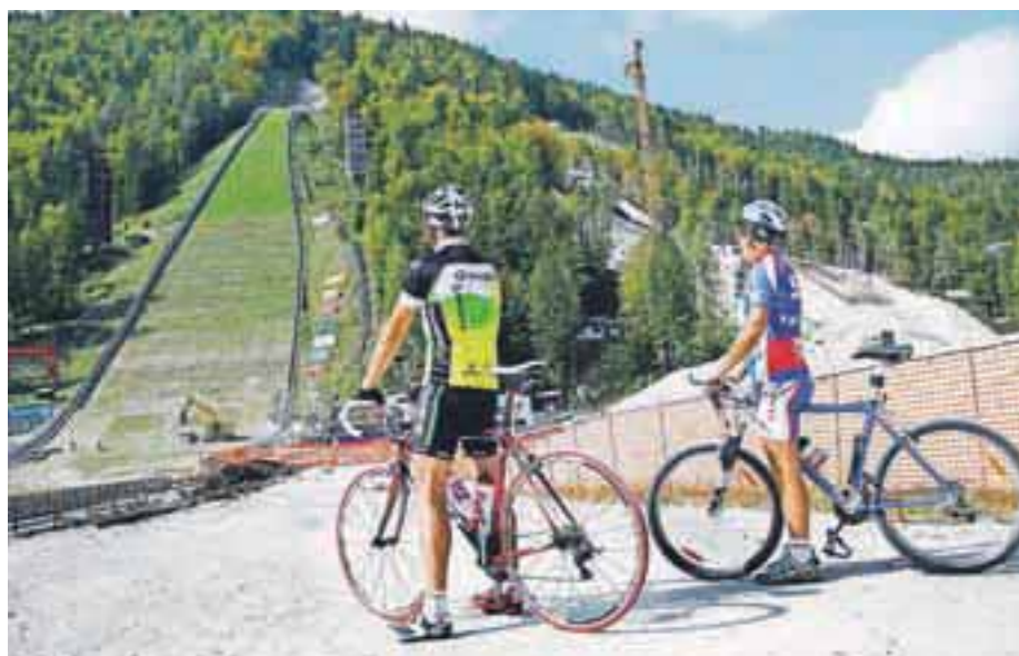
Planica, to jesen veliko gradbišče / Foto: Gorazd Kavčič
