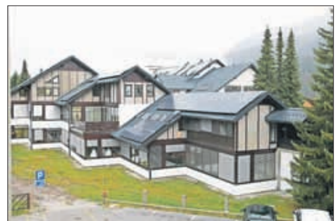
Na strehi obnovljene Osnovne šole Josipa Vandota Kranjska Gora so novembra zaključili montažo fotovoltaične elektrarne.
