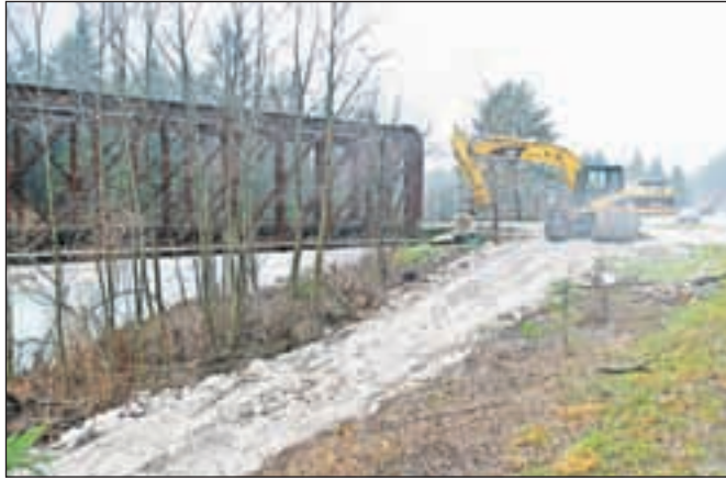
Utrditi je potrebno tudi poškodovano brežino pri nekdanjem železniškem mostu na kolesarski stezi. / FOTO: GORAZD KAVČIČ
