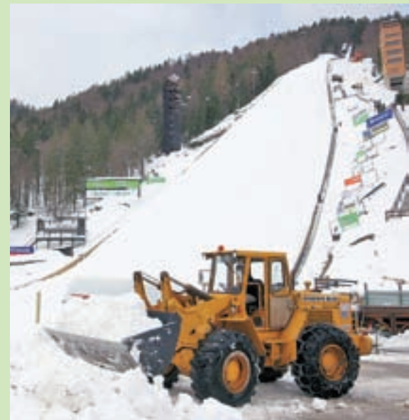
V Planici priprave na svetovno prvenstvo v poletih potekajo po načrtih.
