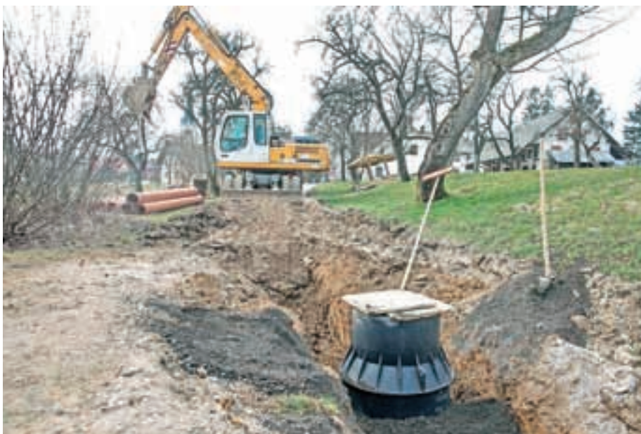
Gradbena dela na Srednji Beli
