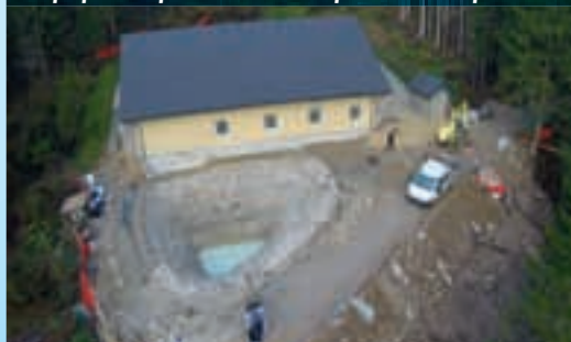
Izvajanje zunanje ureditve in dostopne ceste za objekt
