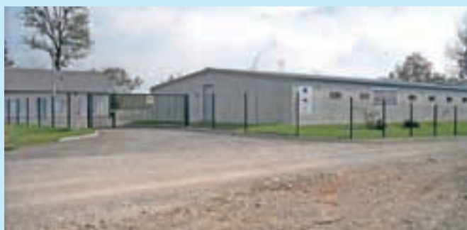
Čistilna naprava v Tupaličah
