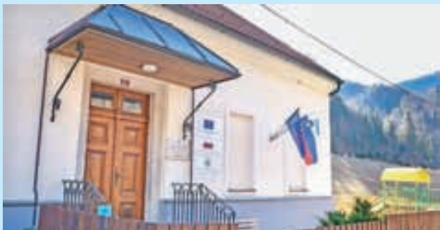
Energetsko obnovljena šola v Kokri / Foto: Primož Pičulin
