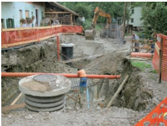
V Bašlju gradijo kanalizacijo.
