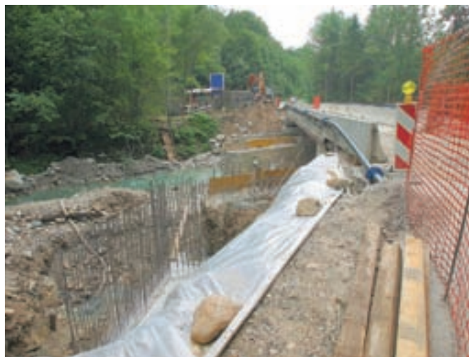
Dolina Kokre je znova gradbišče.
