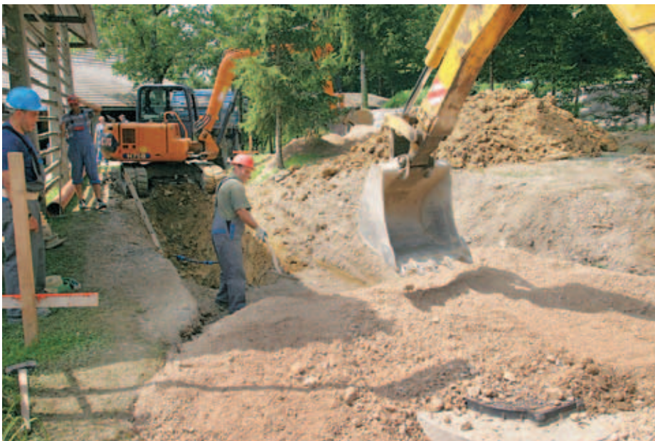
Gradnja kanalizacije v Novi vasi / Foto: Gorazd Kavčič
