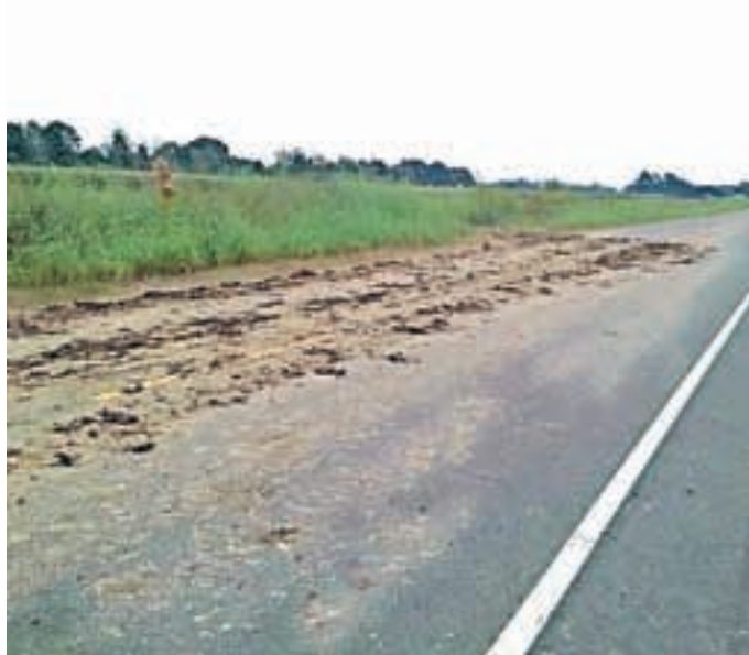
Poljedelec je dolžan, da s pnevmatik in delovnih strojev očisti blato, preden zapelje na javno cesto.
