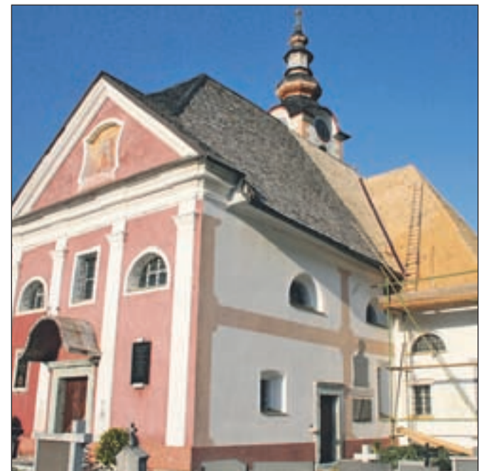
Letos so dokončali obnovo strehe na cerkvi v Lomu.
