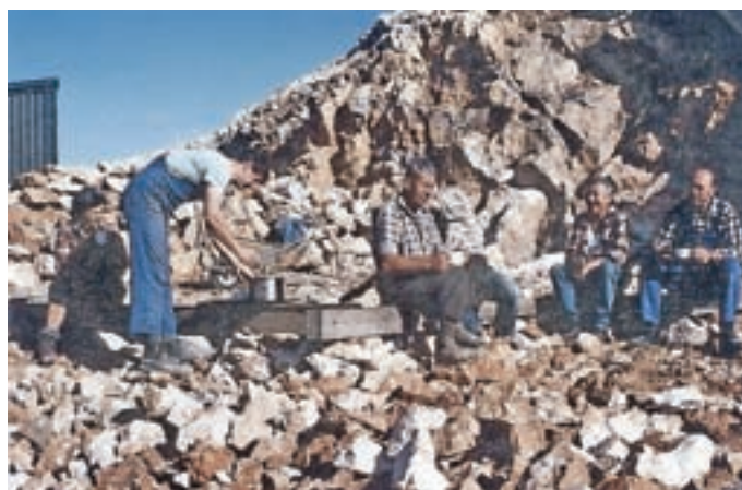
Temeljno ploščo za kapelico Marije Snežne so zabetonirali 21. septembra 1991. Marjan Černivec se z žarom v očeh spominja, kako so delali s pozitivno energijo in »na horuk«, kot so takrat rekli, dela pa so bila zaključena v rekordnem času. Beton so mešali z enim betonskim mešalcem in ročno. Vodo so imeli v bližini, saj je pod Domom na Kredarici zajetje ledeniške vode. Vsi so na visokogorsko delovno mesto hodili peš, le gradbeni material so vozili s helikopterjem, enkrat zaradi slabega vremena celo s konji. / Foto: osebni arhiv Marjana Černivca
