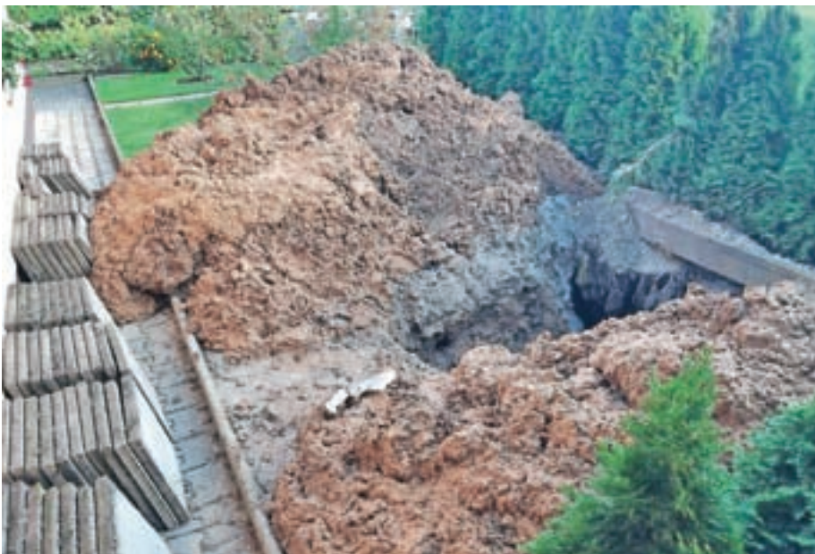
Popravilo vodovodnega omrežja v Hrašah / Foto: arhiv Marjana Rekarja
