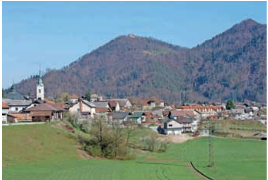
Projekt, ki se je začel leta 2010, vključuje tudi gradnjo kanalizacijskega omrežja v Verjah, Sp. in Zg. Pirničah in delu Vikrč.
