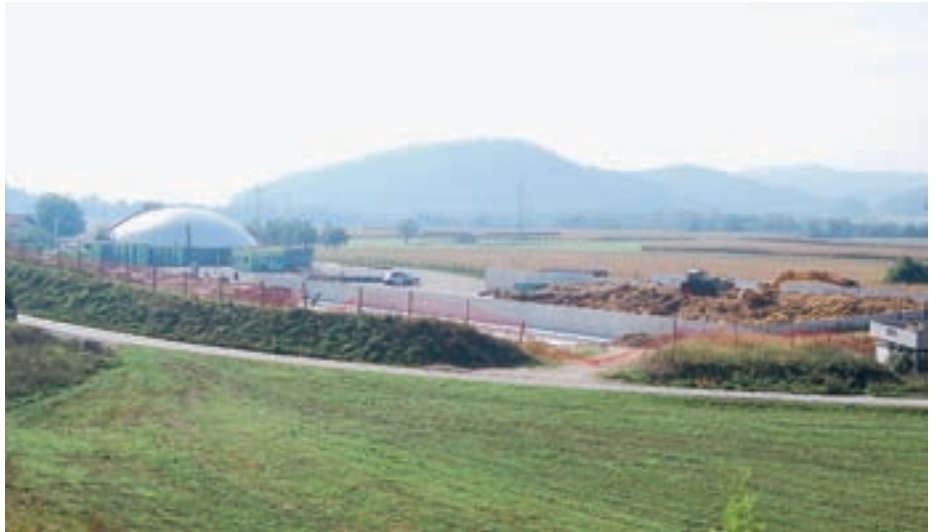
Pri bioplinarni je bil tudi zdravstveni inšpektor, ki je opravil izredni nadzor in že določil ukrepe.
