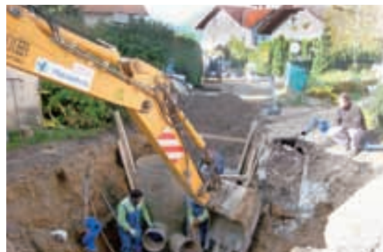
V Zgornjih Pirničah pospešeno gradijo kanalizacijo.
