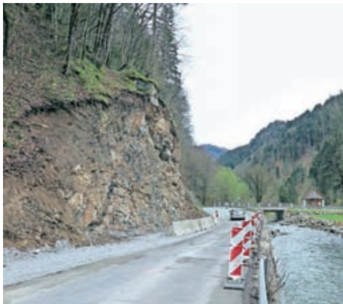
Sanacija brežine ob regionalni cesti pri odcepu za Davčo
