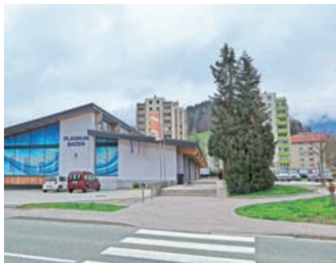
Gradnja nove povezovalne ceste mimo plavalnega bazena naj bi potekala od začetka maja do konca julija.
