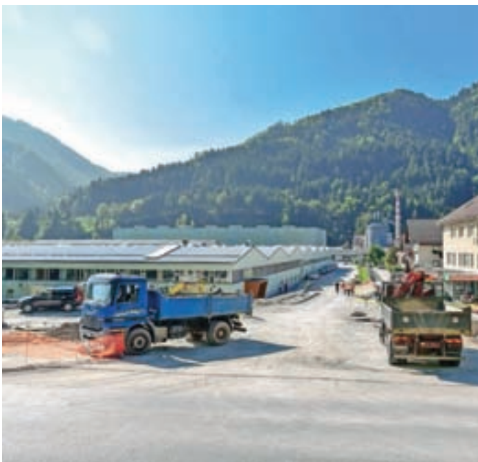
Preglednost uvoza v poslovno cono se bo po rekonstrukciji precej izboljšala. / Foto: Andrej Tarfila
