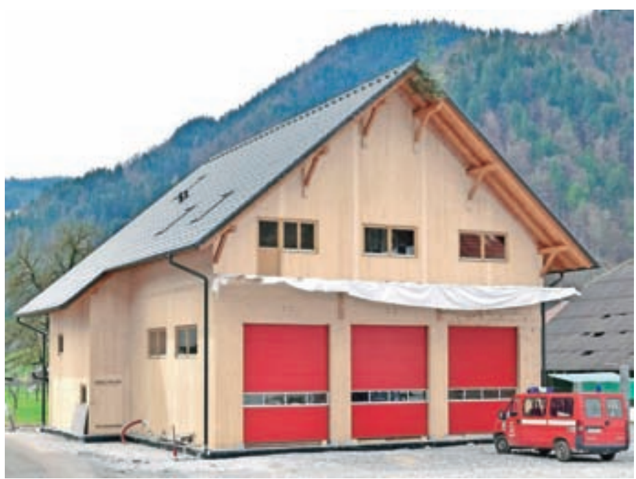
Gasilci v Selcih nadaljujejo gradnjo doma. Zadnja pridobitev so garažna vrata.
