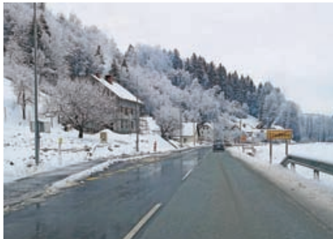
Občina Železniki je pred dnevi končala še zadnjo letošnjo večjo investicijo – gradnjo pločnika na Studenem.
