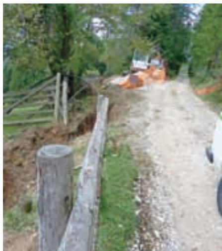
Na 1300 metrov visoki planini Rakeževo nad Jezerskim vrhom bo z bazno postajo mobilne telefonije »pokrita« dolina, kjer doslej ni bilo signala. Radi bi dodali še kamero »s pogledom na dobršen del ene največjih občin v Sloveniji«, pravi župan Jure Markič.
