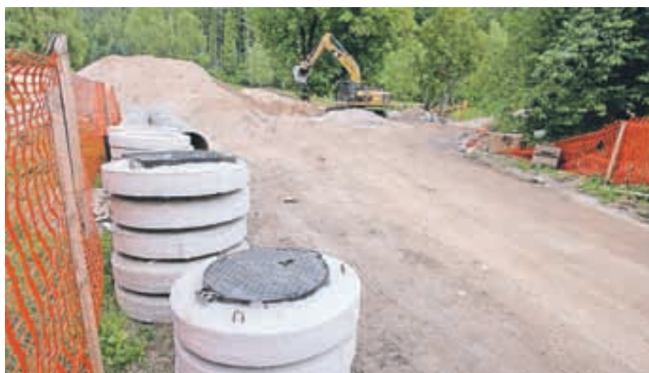
Gradnja kanalizacije na Jezerskem gre h koncu. / Foto: Tina Dokl
