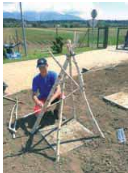
Postavljanje konstrukcije za vzpenjavke / Foto: T. Jenko
